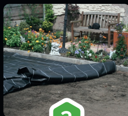
2 Lay geotextile membrane
